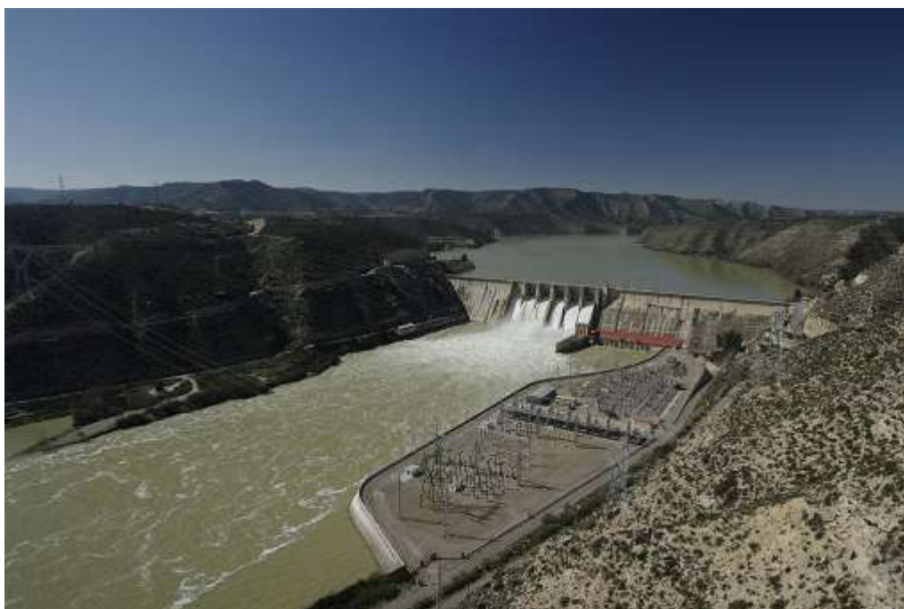
Figura 3.11.- Presa y Central de Mequinenza
