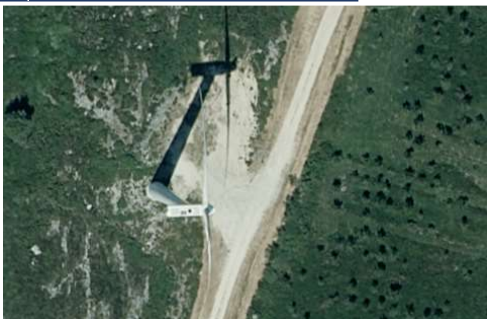
Figura 10.56. Aerogenerador y pista de acceso en el Monte Ferreira (Concello de Aranga) dentro de la Reserva de Biosfera Mariñas Coruñesas e Terras do Mandeo.
