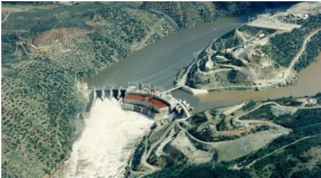
Figura 3.9. Presa de Cedillo (Cáceres, Extremadura). Fuente: IAGUA Data.
