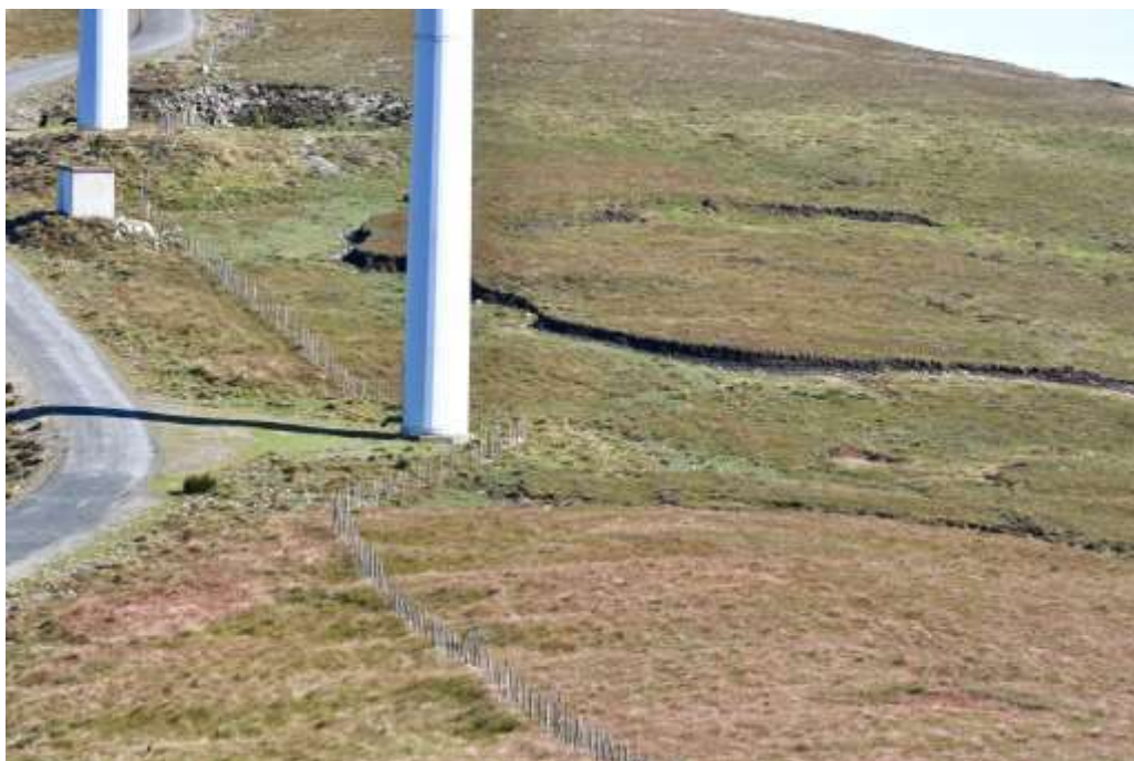
Figura 10.71. Detalle de la ubicación de las pistas del parque eólico y de los aerogeneradores sobre la turbera de cobertor de Chan do Lamoso (ZEC Serra do Xistral),
