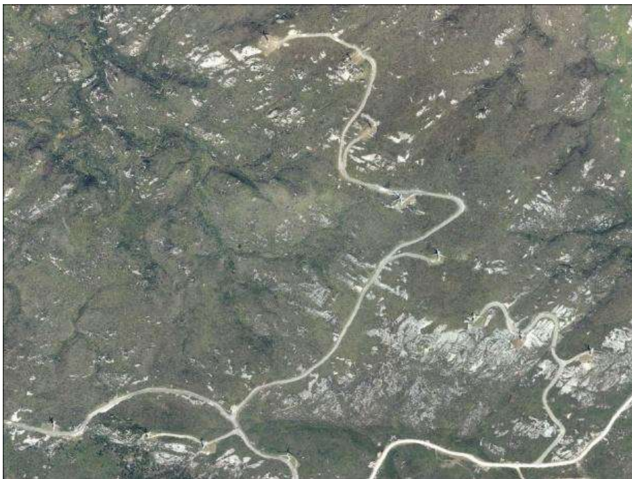
Figura 10.22. Instalación de un parque eólico en la actual ZEC Serra do Xistral (zona núcleo de la Reserva de Biosfera Terras do Miño) sobre turberas altas y, brezales húmedos (Nat-2000 7110*, 4020*), entre 2003 (ortoimagen SIGPAC) y 2011 (ortoimagen del PNOA).
