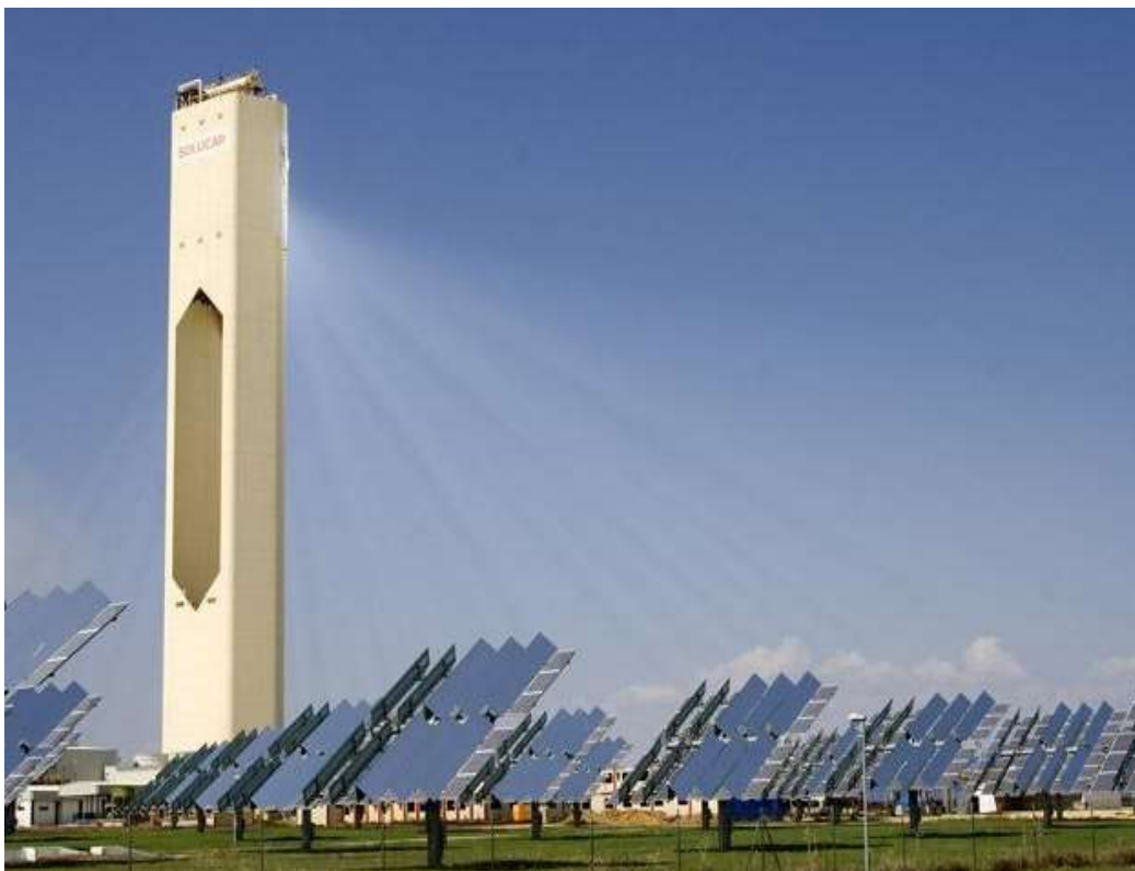
Figura 8.14. Imagen superior: Fotografía satélite en las que se observan las dos centrales termo solares ubicadas en Sanlúcar la Mayor (Sevilla). La PS20 (izquierda) y PS10 (derecha). Foto Google Earth. Imagen inferior: Detalle de la torre y los heliostatos de la PS10. Fuente: Empresarios Agrupados, Sevilla
