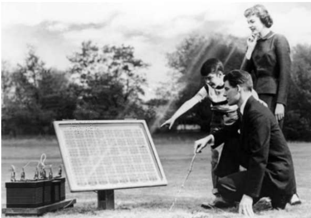
Figura 3.40. Panel solar construido por C. Fritts en 1883. Fotografía: Smithsonian.
