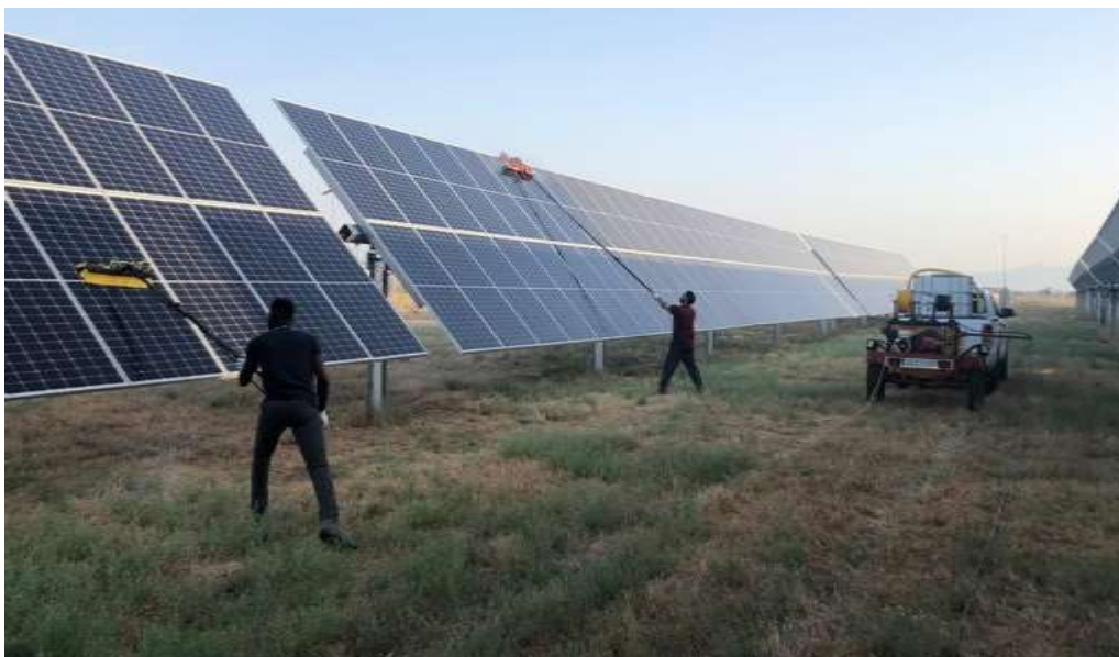
Figura 8.32. Ejemplo de limpieza manual en una Planta Fotovoltaica. Imagen publicada en el Dossier de Trust Ingeniería de Mantenimiento (Olivenza, Badajoz).
