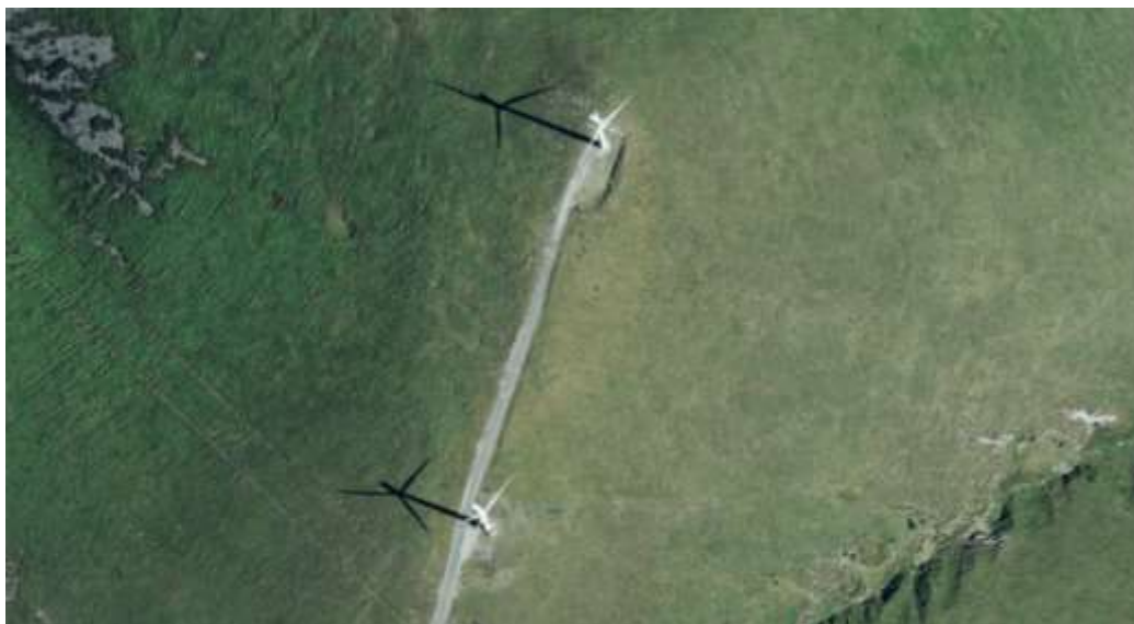
Figura 8.8. Parque Eólico Alabe – Cadramón (Valadouro, Lugo), ubicado en la zona núcleo de la Reserva de Biosfera Terras do Miño. El Parque posee 27 aerogeneradores (Altura de las torres 45, Diámetro de las palas 44 m), de 750 kW, con una potencia instalada de 20,25 MW y una producción anual máxima de 60.138 MW/h/año. Fotografía: Imagen PNOA-2020 de la Cumbre del Cadramón.
