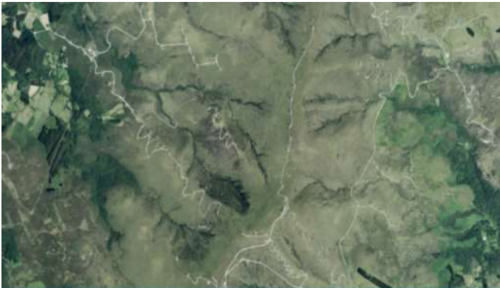
Figura 8.29. Apertura de un vial afectando a humedales de montaña (Nat-2000 7130*, 4020*) en la ZEC Serra do Xistral, Zona Núcleo de la Reserva de Biosfera Terras do Miño. Imagen: PNOA 2020
