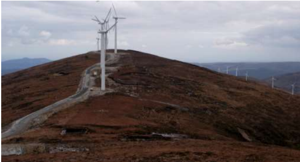
Figura 10.27. Instalación de parques eólicos en el LIC-ZEPVN Serra do Xistral (zona núcleo de la Reserva de Biosfera Terras do Miño) sobre turberas de cobertor (Nat-2000 7130*).
