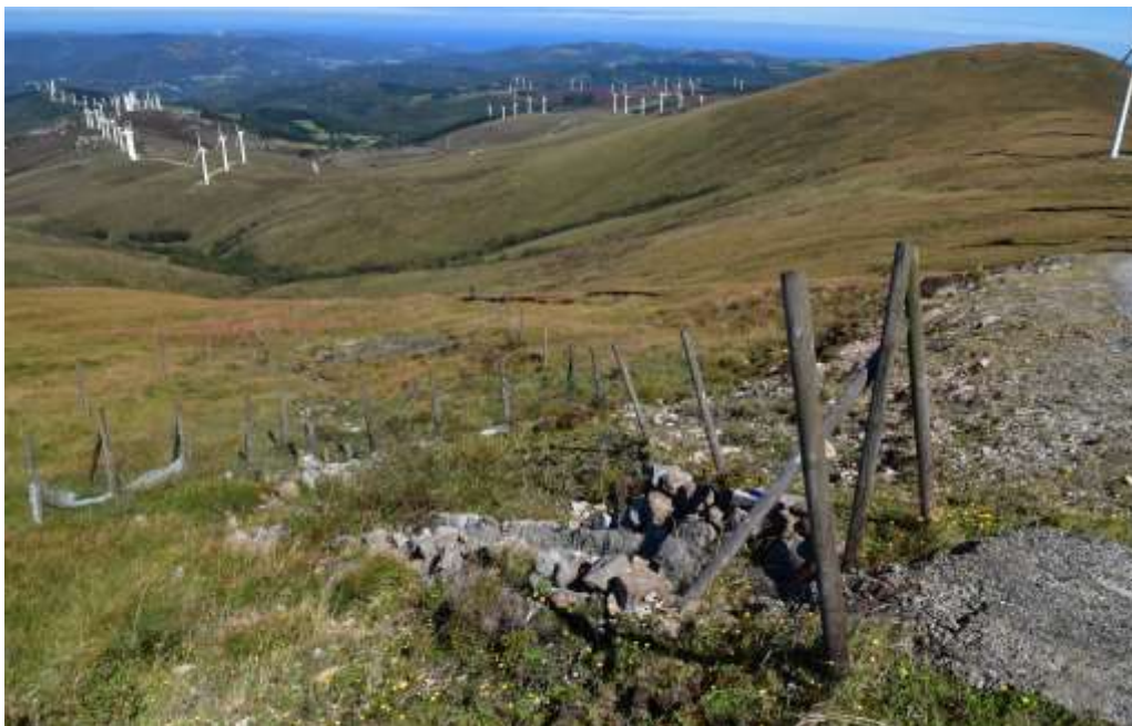
Figura 10.75. Vista lateral del punto de evacuación de aguas en el Parque Eólico de Chan do Lamoso, el mantenimiento de los mismos resulta muy deficiente, de modo que las medidas planteadas para reducir la erosión se ven comprometidas.
