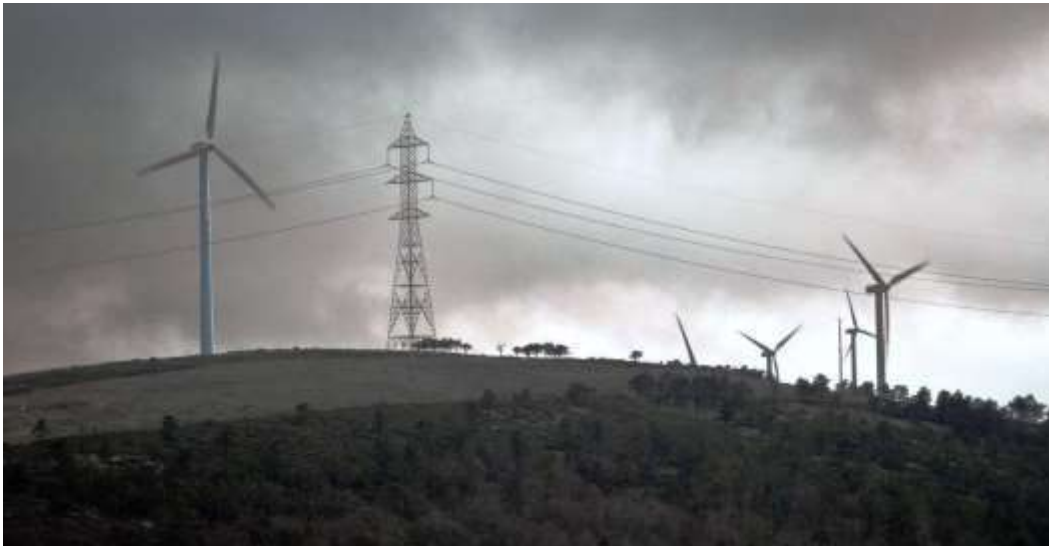
Figura 8.16. Línea eléctrica de alta tensión de Red Eléctrica Española entre San Andrés de Boimente y Pesoz, que con sus 80 km de extensión se emplea para evacuar la energía producida en distintos Parques Eólicos del Norte de Lugo y del Occidente de Asturias
