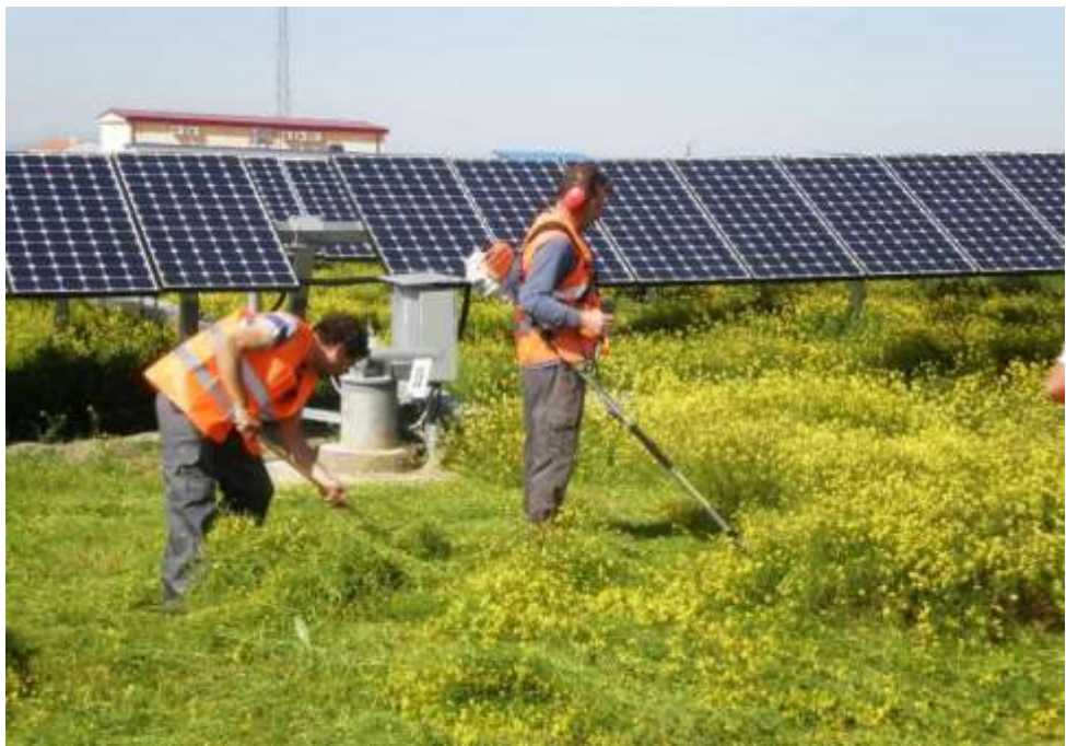
Figura 8.19. Control de vegetación mediante desbroce manual en un Parque Solar. Fotografía tomada de Servex Ingenieros.
