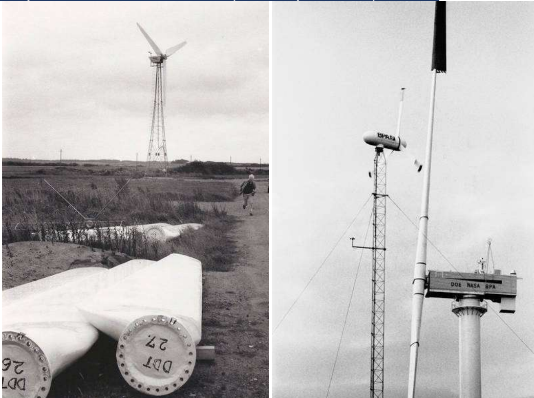
Figura 3.22. Fotografía de la izquierda montaje en 1980 de un aerogenerador VESPAS modelo HVK con palas Økær Vind Energi. Fotografía de la derecha aerogenerador de Boeing-EnerTech. Fotografías tomadas de wind-works.org.
