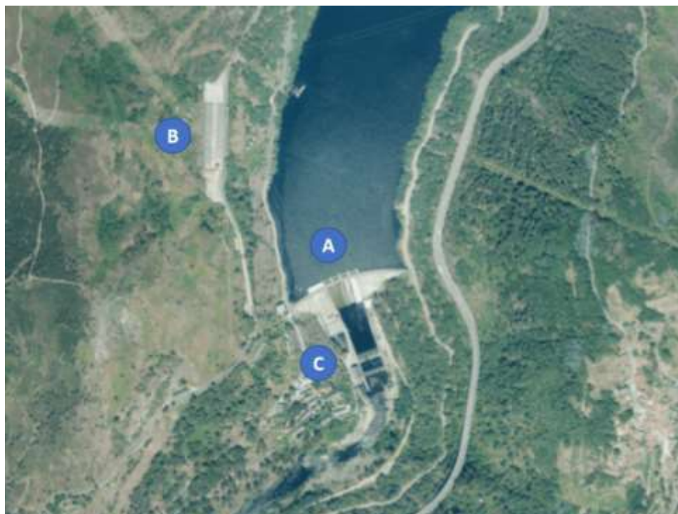
[A].- Presa de Os Peares inaugurada en 1955. La presa tiene una altura de 94 m, con una capacidad de 182 hm 3 . La superficie de aguas embalsadas se extiende por una superficie de más de 540 ha, hasta el pie de la presa de Belesar. [B].- Central Hidroeléctrica de Os Peares (Os Peares I), que entró en funcionamiento en 1955. [C].- Central Hidroeléctrica de Os Peares II, puesta en funcionamiento en 2013, situada al pie de la presa de Os Peares y que turбина el caudal ecológico
