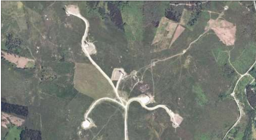
Figura 10.36. Instalación de parques eólicos en la zona de transición de la Reserva de Biosfera Terras do Miño, sobre brezales húmedos (Nat-2000 4020*).
