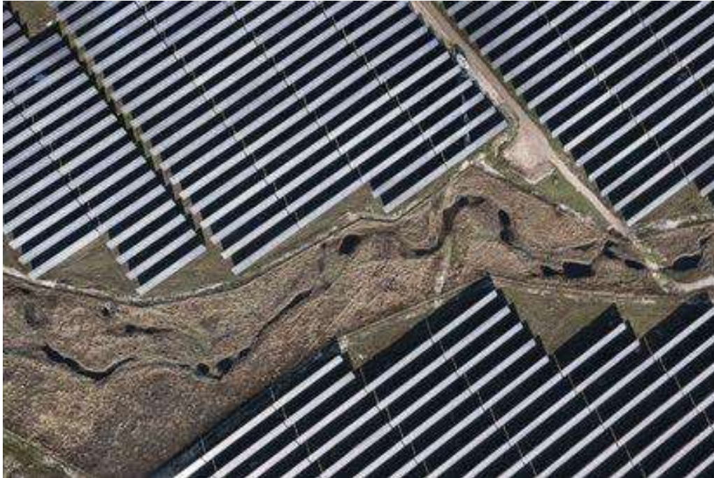
Figura 8.3. Vista aérea del Parque Fotovoltaico de Talayuela (Cáceres). El Parque ocupa un polígono de 820 ha, de las cuales 500 ha (61%), están ocupadas por paneles solares. Algunos de los elementos del paisaje primitivo, como el curso fluvial y las charcas que se muestran en la figura, se han preservado, generando islas en medio de un nuevo paisaje artificial de reducida naturalidad y diversidad. Fotografía: El País.
