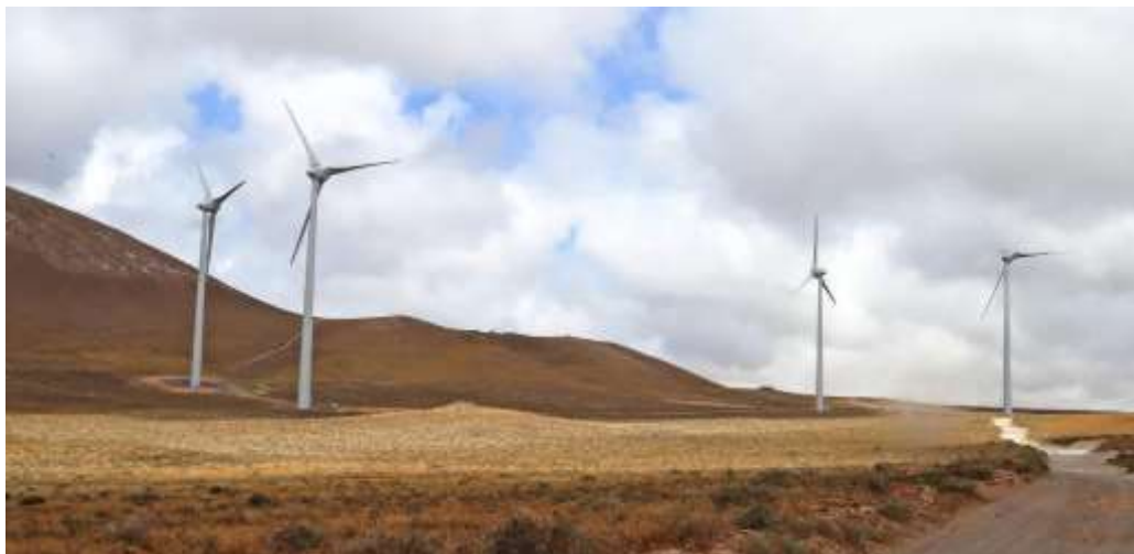
Figura 8.7. Vista del Parque Eólico de Arrecife (San Bartolomé en Lanzarote) ubicado en la Reserva de Biosfera de Lanzarote. El parque este compuesto por 4 aerogeneradores (altura del buje de 85 m. Diámetro rotor de 71 m. Altura máxima, con las palas, de 120 m), una potencia total instalada de 9,2 MW y produce 27.150 MW/h al año. Fotografía: La Voz de Lanzarote.
