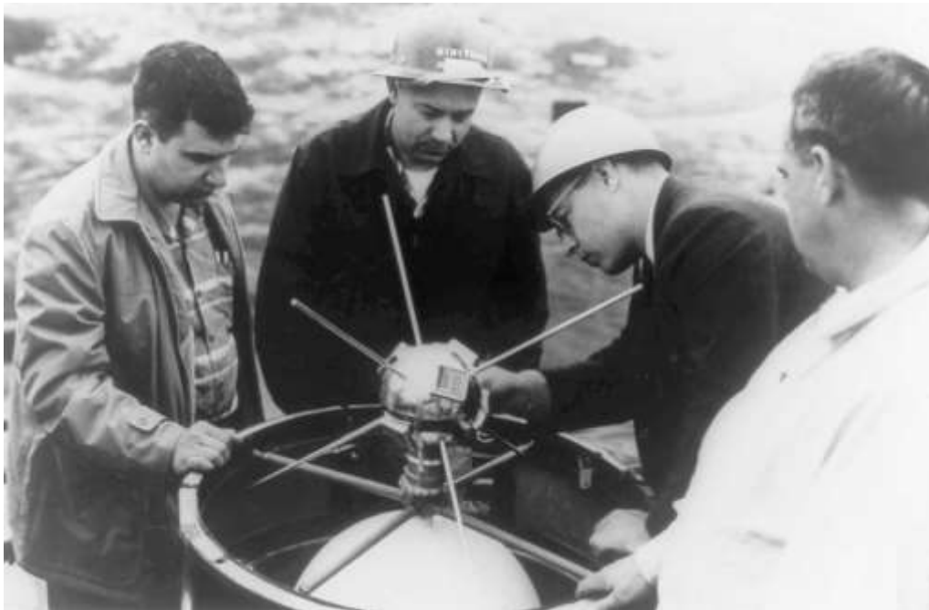
Figura 3.42. El satélite Vanguard fue lanzado el 17/03/1958, siendo el segundo satellite artificial americano puesto en órbita alrededor de la tierra. El satellite era una pequeña esfera de 1,47 kg, equipada con dos transmisores de radio. En la fotografía, que corresponde a una prueba previa al lanzamiento, se observa las pequeñas placas fotovoltaicas sobre la esfera. Fotografía: Britannica.
